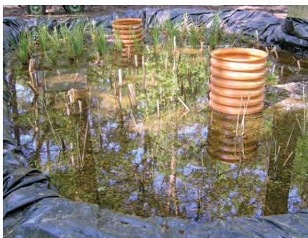
Obr. 18. Maloplošná kořenová čistírna odpadních vod po výrobě výbušnin (foto T. Vaněk)
